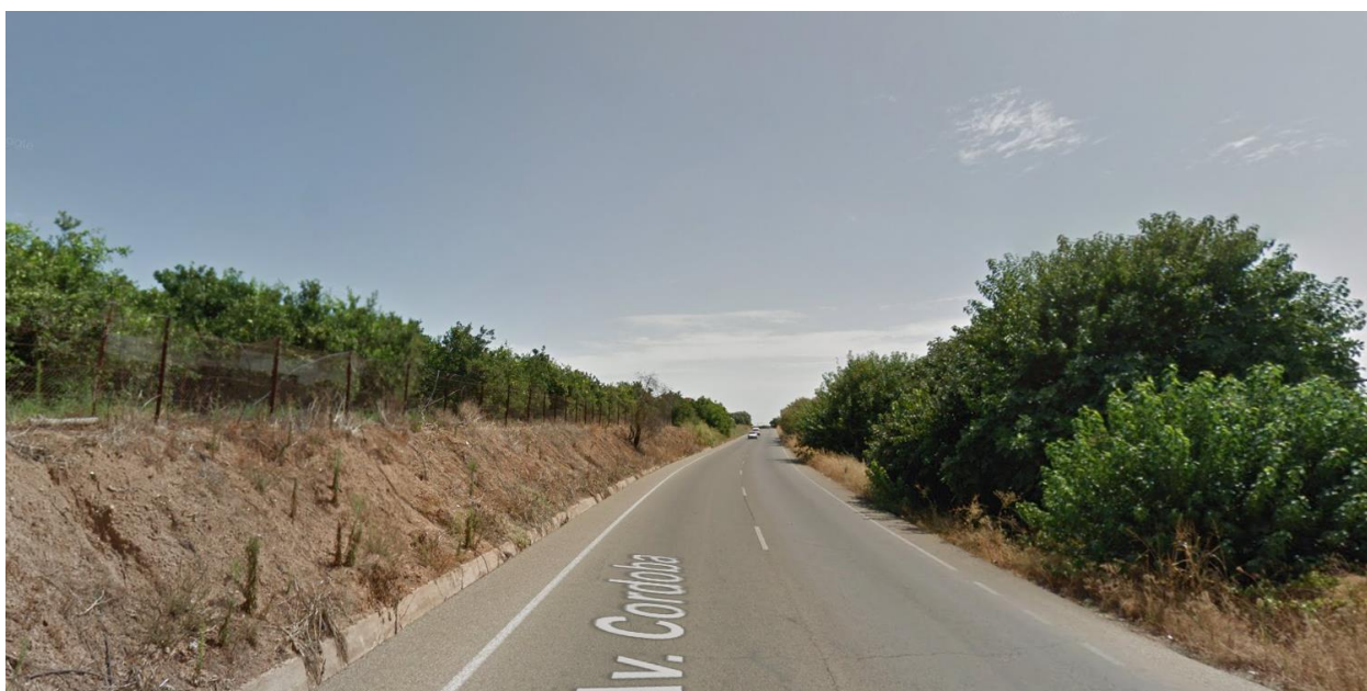
Foto 4. Tramo urbano de la carretera A-431 de acceso al sector.
